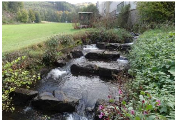
Fischwanderhilfe (Foto: LANUV NW)
