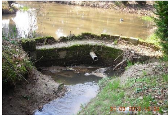
Damm (Foto: LANUV NW)
