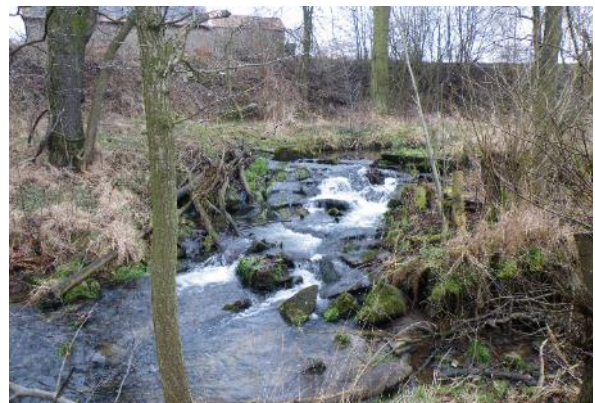
raue Gleite/Rampe (Foto: LfULG SN)
