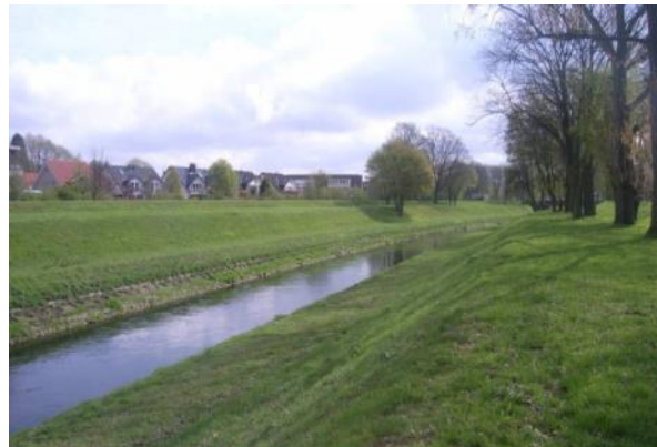
Hochwasserschutz (Foto: LANUV NW)
