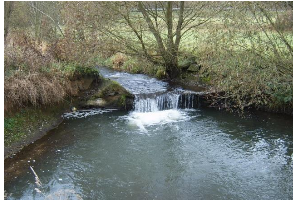
Absturz 0,3 - 1 m (Foto: HLNUG)
