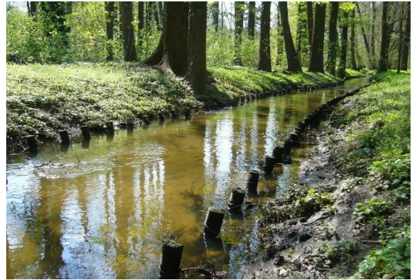
verfallender Uferverbau (Foto: T. Pottgiesser)
