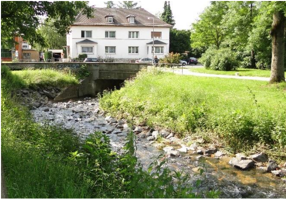
Steinschüttung (Foto: HLNUG)
