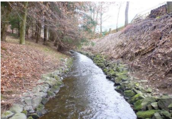
Steinschüttung (Foto: LANUV NW)
