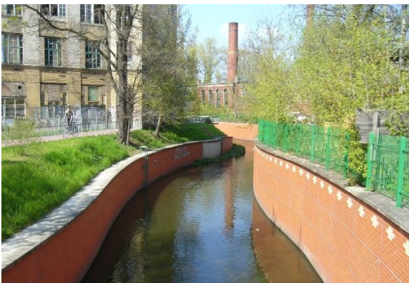
massiver Verbau (Foto: T. Pottgiesser)
