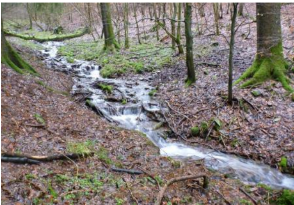
ausgeprägte Sohlstufen (Foto: LANUV NW)
