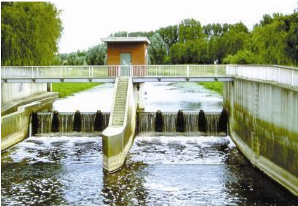
Wehr, beweglich > 1 m (Foto: LANUV NW)
