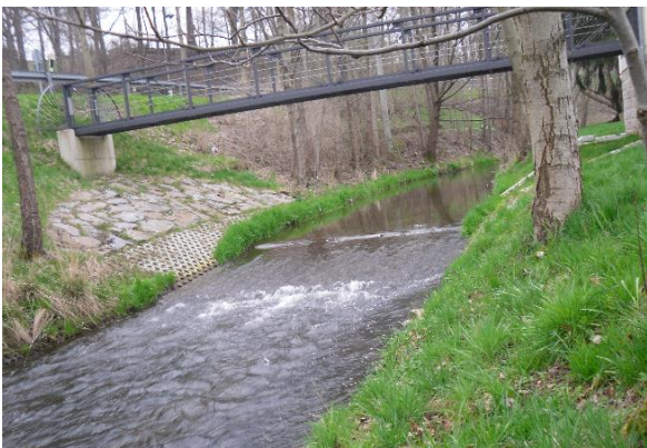
glatte Gleite/Rampe (Foto: LfULG SN)
