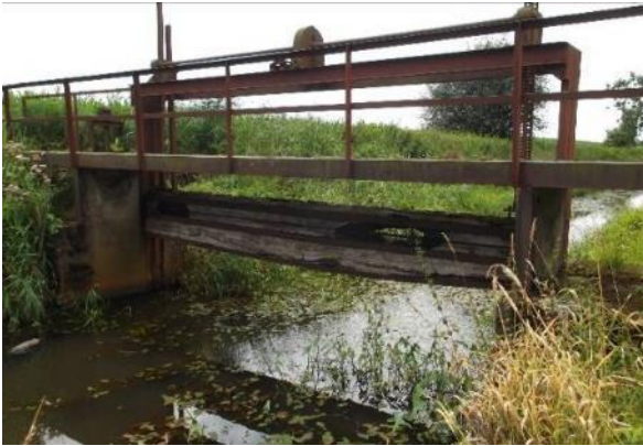
Schütz/QBW mit sohnahem Ablauf (Foto: LANUV NW)
