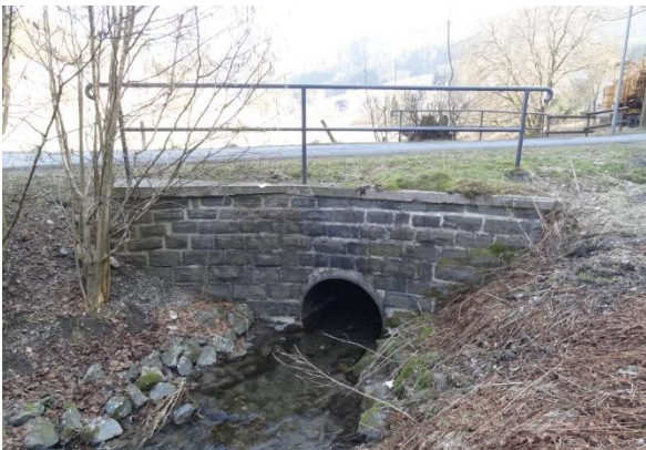
Lauf verengt mit Sediment (Foto: LANUV NW)
