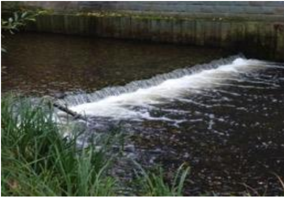
Absturz < 0,3 m (Foto: LANUV NW)
