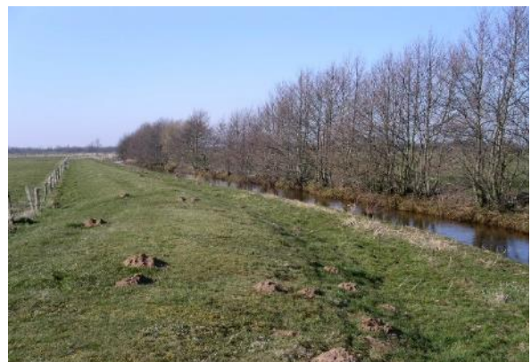
Hochwasserschutzbauwerk (Foto: ube)
