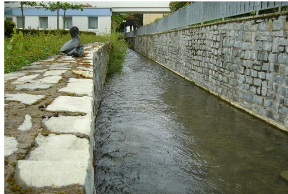
Regelprofil: Kastenprofil (Foto: T. Pottgiesser)
