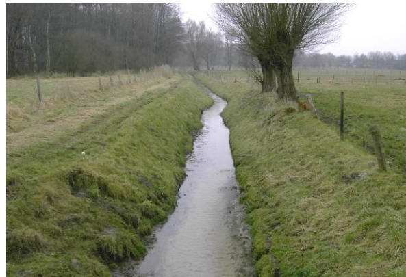
Regelprofil: Trapezprofil (Foto: T. Pottgiesser)
