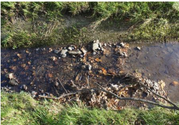
Massivsohle mit Sediment (Foto: LfULG SN)
