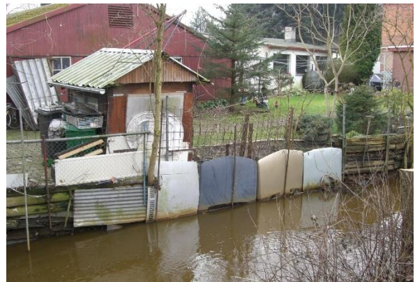
wilder Verbau (Foto: M. Stöver)
