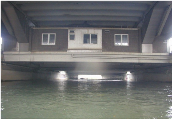
Überbauung (Foto: Planungsbüro Koenzen)
