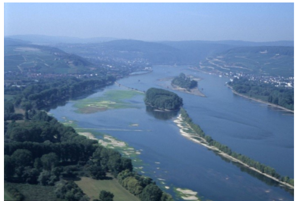
Profil mit Längsbauwerk (Foto: LfU RP)
