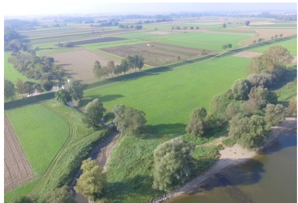
Hochwasserschutzbauwerk (Foto: PB Koenzen)
