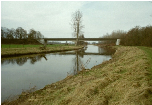
nicht bodenständiges Gebüsch, Einzelgehölze Foto: (Planungsbüro Koenzen)
