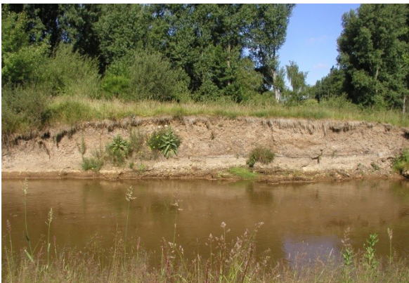
Steilwand (Foto: Planungsbüro Koenzen)
