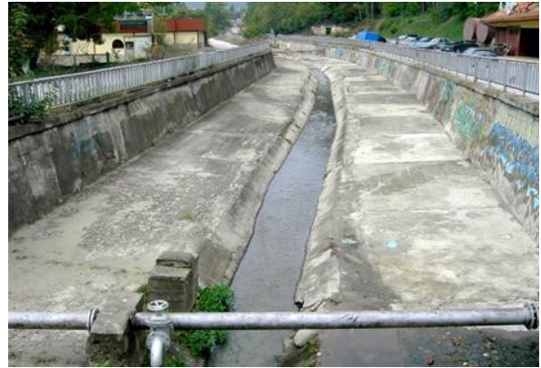
Massivsohle ohne Sediment (Foto: R. Bonn)
