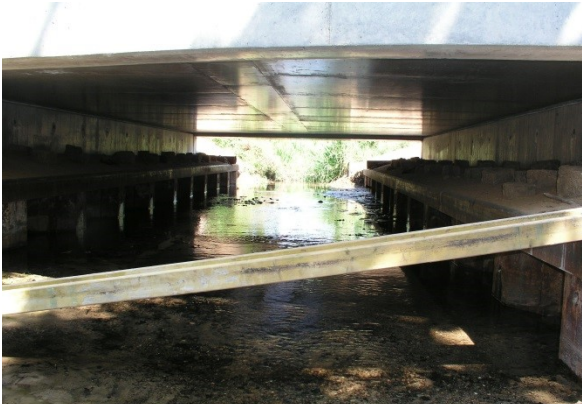
Durchlass, Ufer unterbrochen (Foto: Planungsbüro Koenzen)
