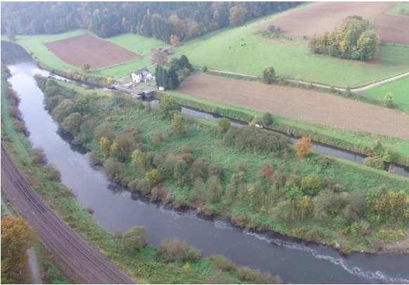
Ausleitung (Foto: Planungsbüro Koenzen)
