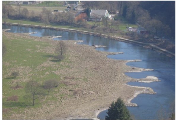
Profil mit Bühnenausbau (Foto: R. Bonn)
