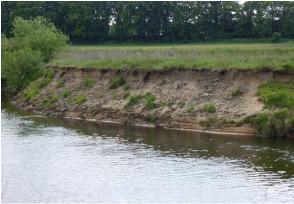
kein Uferbewuchs, naturbedingt (Foto: Planungsbüro Koenzen)
