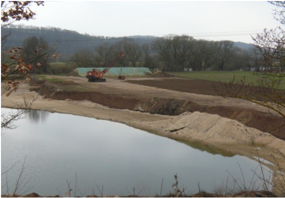
Abgrabung (Foto: Planungsbüro Koenzen)
