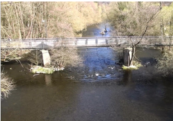
Durchlass, nicht strukturschädlich (Foto: Planungsbüro Koenzen)
