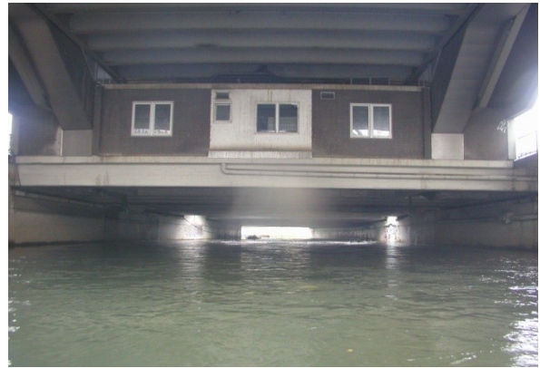
Überbauung (Foto: Planungsbüro Koenzen)
