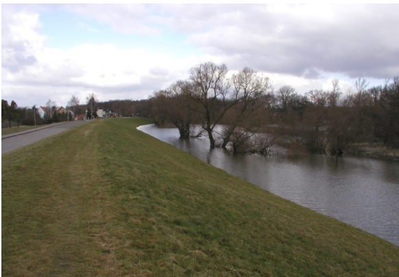
Hochwasserschutz (Foto: PB Koenzen)
