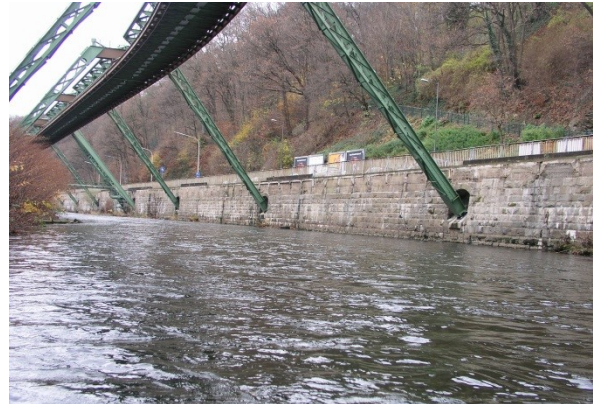
massiver Verbau/Mauer (Foto: Planungsbüro Koenzen)
