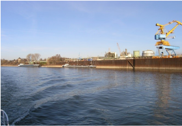
massiver Verbau/Spundwand (Foto: Planungsbüro Koenzen)
