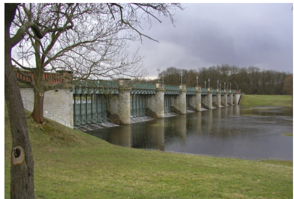
Querbauwerk m. sohl-nahem Ablauf (Foto: Planungsbüro Koenzen)
