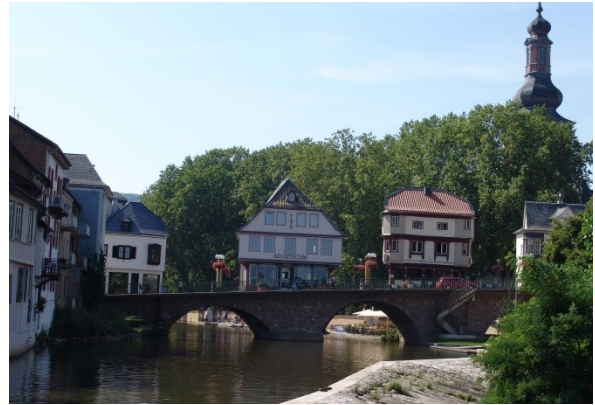
Durchlass, Lauf verengt, glatt (Foto: LfU Rheinland-Pfalz)
