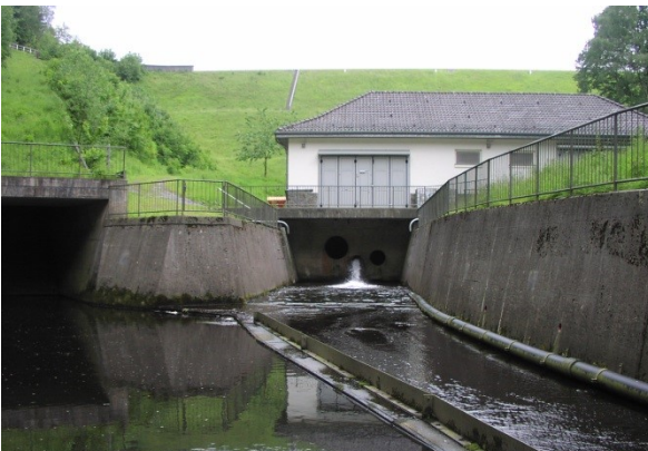
Talsperre (Foto: Planungsbüro Koenzen)
