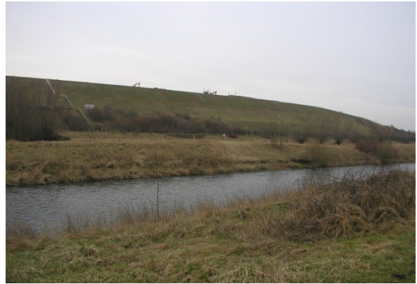
Anschüttung (Foto: Planungsbüro Koenzen)
