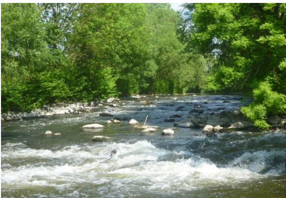
raue Rampe (Foto: Planungsbüro Koenzen)
