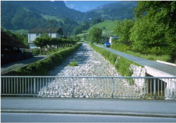
Steinschüttung (Foto: LfU Rheinland-Pfalz)
